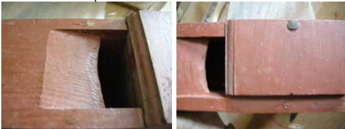
Holzpfeifen G und H vor der Restaurierung; deutlich erhöhte, bogenförmige Aufschnitte
